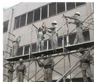
足場の組立実習
