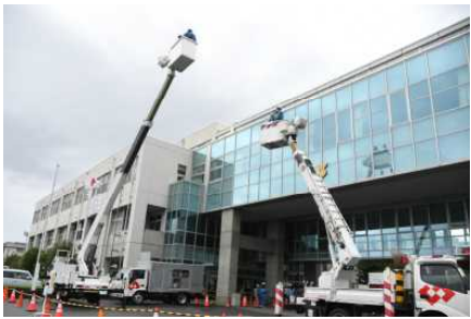
【電気系の高所作業体験】
