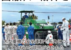
大型重機の安全運転や死角について、正しい安全説明がなされた
